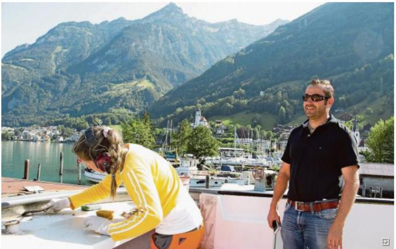
Matthias Steinegger beim Besuch der Baustelle «Wilhelm Tell».Bild: Bruno Arnold
