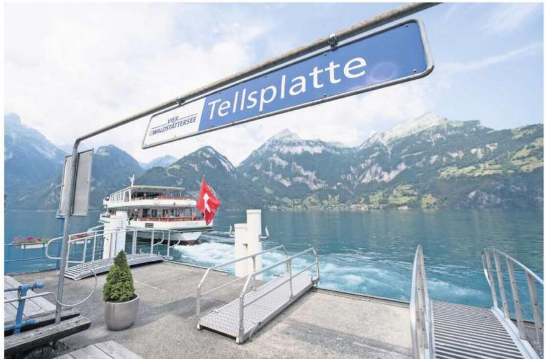
Die Schiffsstation Tellsplatte wurde für rund 600 000 Franken saniert.
