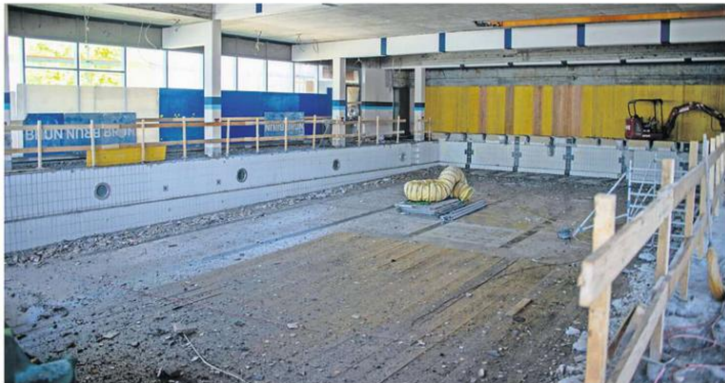
Das Hallenbad in Brunnen wird einer umfangreichen Sanierung unterzogen. Unser Bild zeigt das grosse Schwimmbecken.
