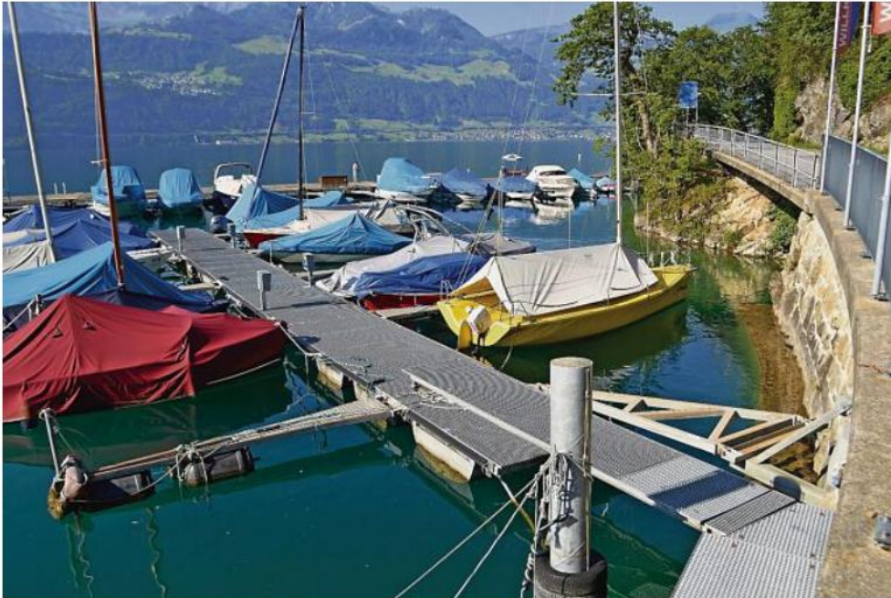
Die Uferpartie entlang der Seestrasse wird totalsaniert. (Silvia Camenzind, Bote der Urschweiz)
