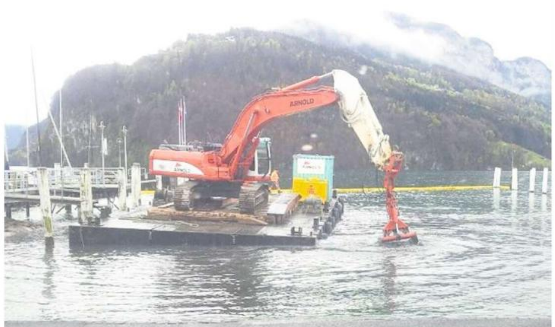
Im Frühjahr 2014 arbeitete ein Bagger im Föhnhafen Brunnen.
