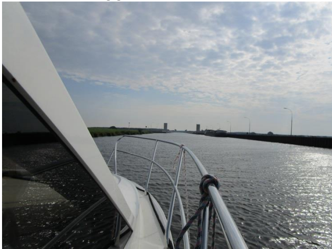
Kanalbrücke, Trog genannt vor, während und nach der überfahrt
