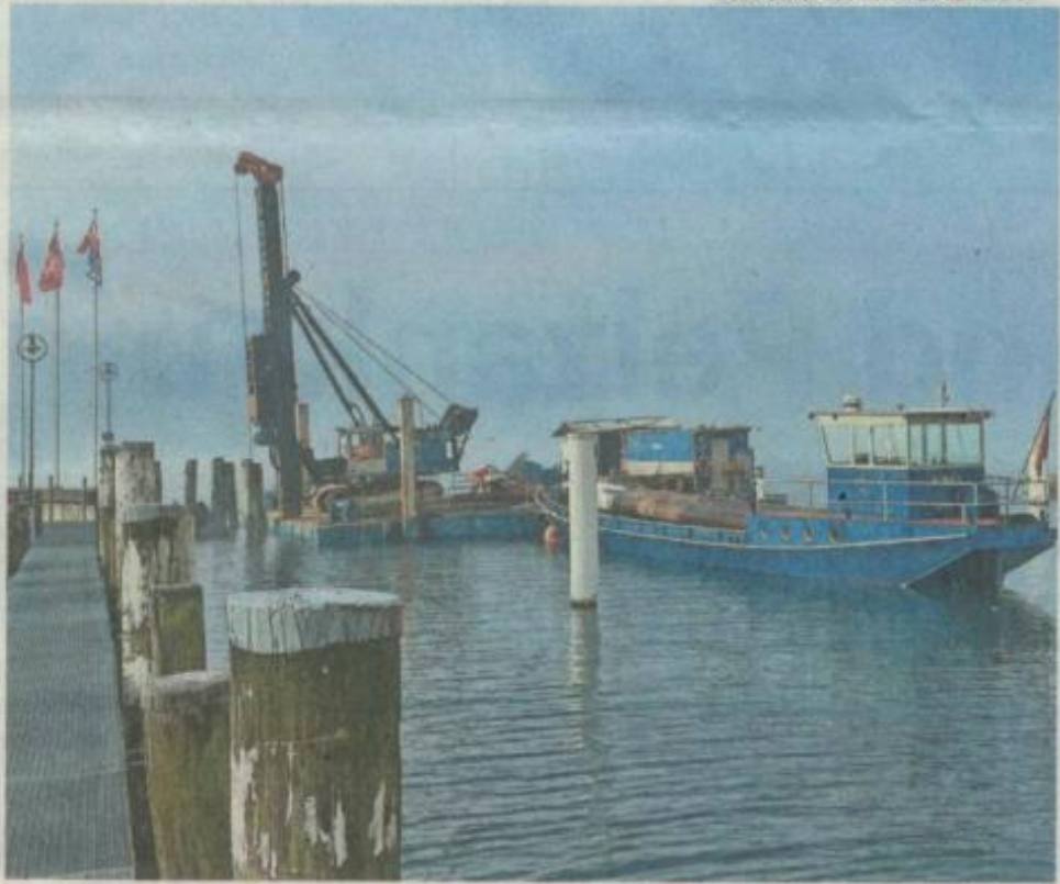
Die Rambagger im Föhnhafen in Aktion.
