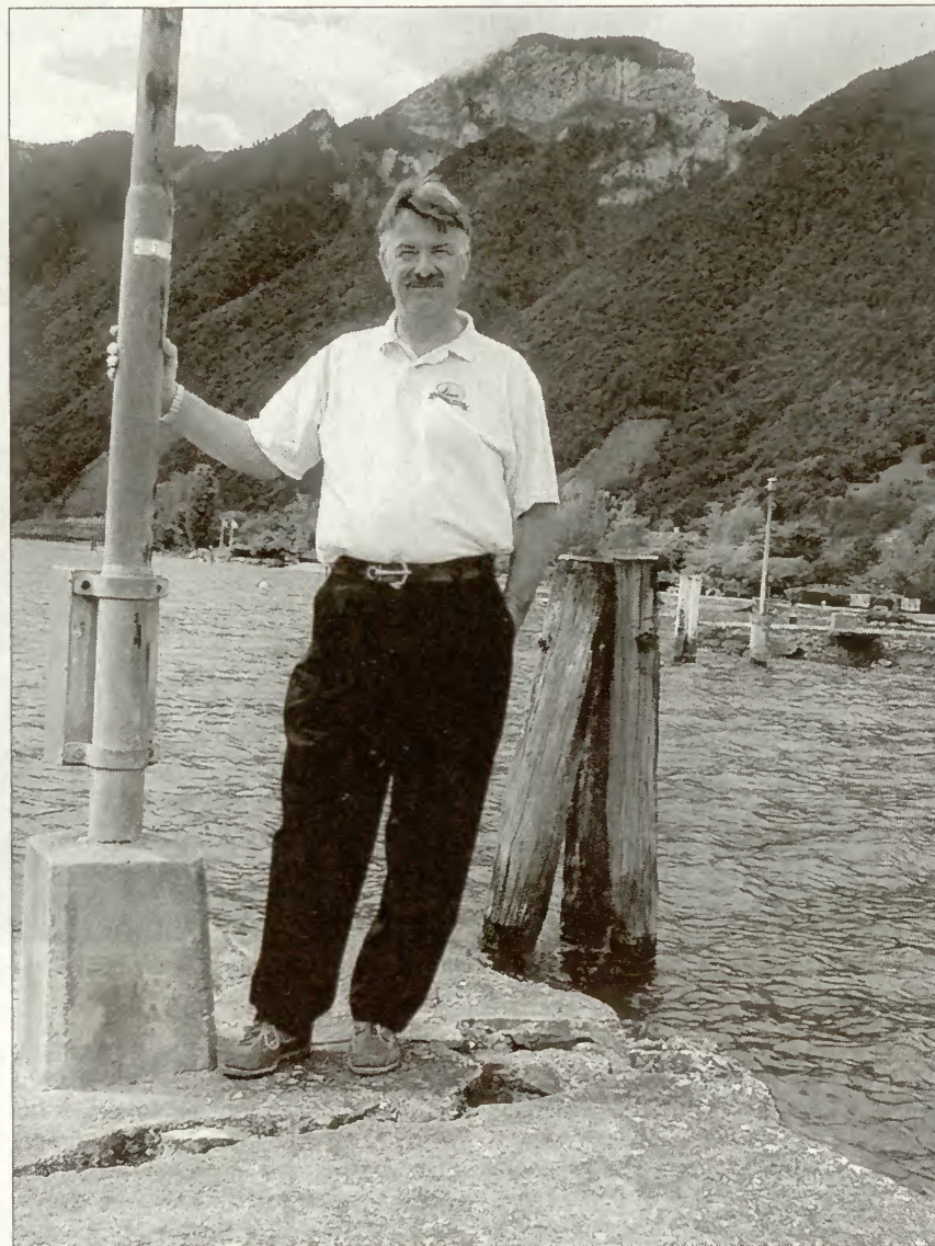
Urs Koller, Präsident der IG Föhnhafen, ist zuversichtlich, dass die dringend nötigen Sanierungsarbeiten bald ausgeführt werden.
