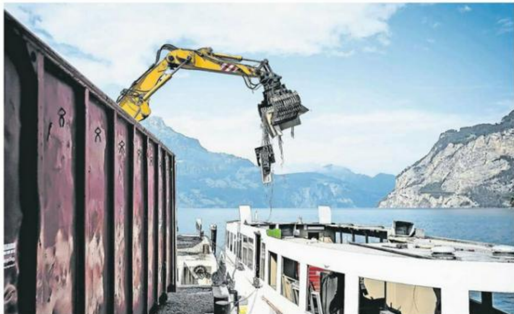
Das Motorschiff Mythen wird in Flüelen in seine Einzelteile zerlegt. Bild: PD
