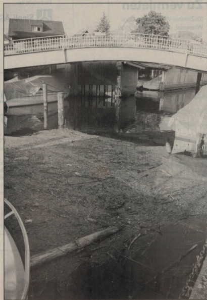
Auch bei der Mündung des Leewassers in den Föhnhafen keine Zierde der ganzen Anlage: Kehricht und Schwammgut stauen sich regelmässig auf.
