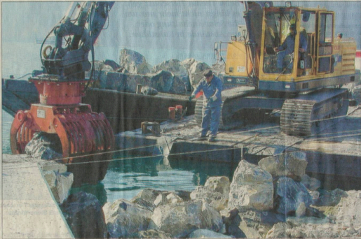
An der Molenspitze des Föhnhafens wird tüchtig gebaggert. Die alte Mole drohte im See zu versinken. Wellenbrecher werden platziert. BILD: SAMUEL NIDERÖST
