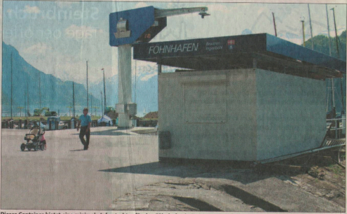
Dieser Container bietet eine minimale Infrastruktur für den Föhnhafen in Brunnen. Eine definitive Lösung kommt erst mit der geplanten Seefestgestaltung.
