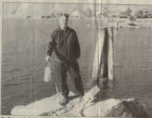
Der Brunner Urs Keller, «Nüü Schilling»-Präsident, steht auf dem alten Molenkopf. Die Sanierungsarbeiten sind bereits im Gange.
